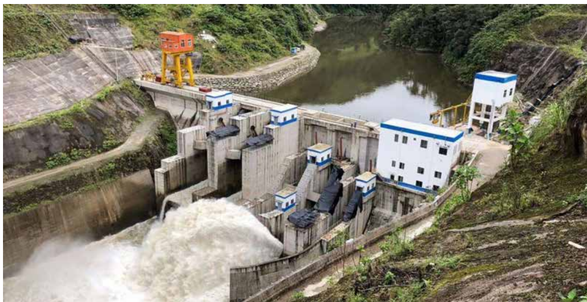
Figura Nro. 4-5: Presa de la Central Hidroeléctrica Delsitanisagua (180 MW). Fuente: CELEC EP ( www.celec.gob.ec ).
