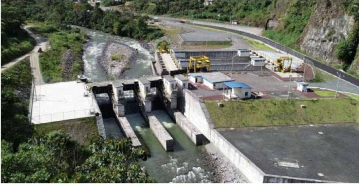
Figura No. 4-31: Captación del río Pilatón, Proyecto Hidroeléctrico Toachi – Pilatón Fuente: El Comercio, 27.feb.2019
